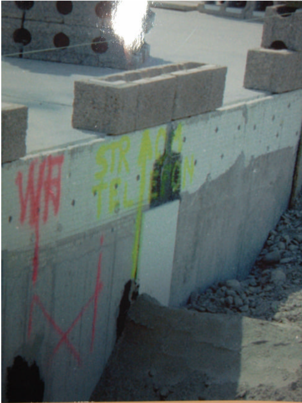
Abdichtung Fuge außen
